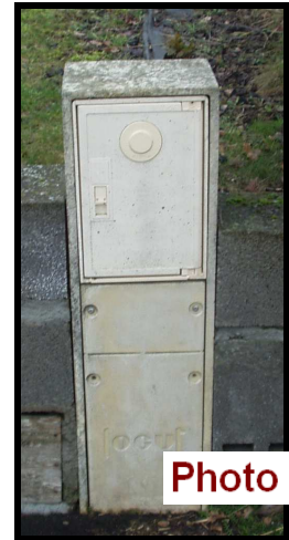
Coffret largeur 23 cm, fermé (serrure triangulaire, accès réservé réséda)
